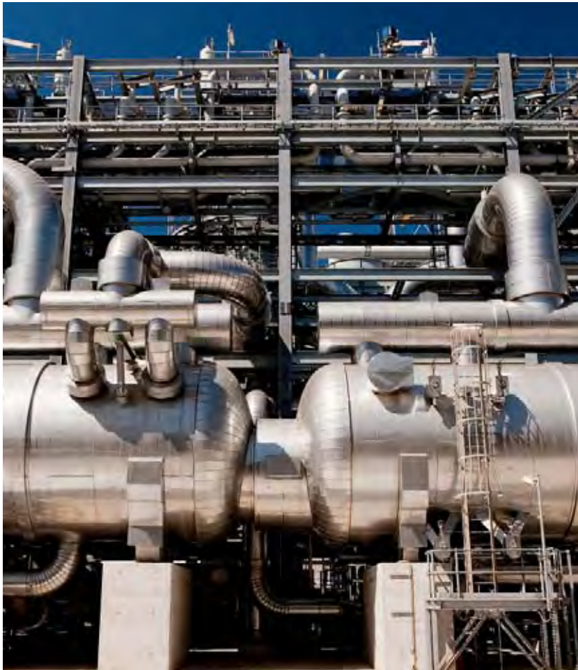
LNG plant, North West Shelf, Australia
